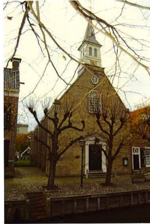
Kerkgebouw te Sloten (Fr.) 1647.
