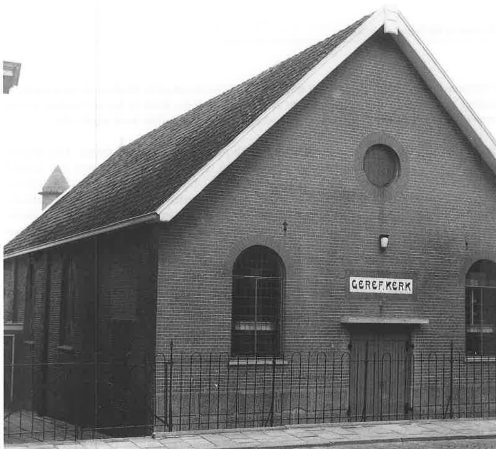
Gereformeerde kerk van Meerkerk, die in 1998 werd afgebroken
