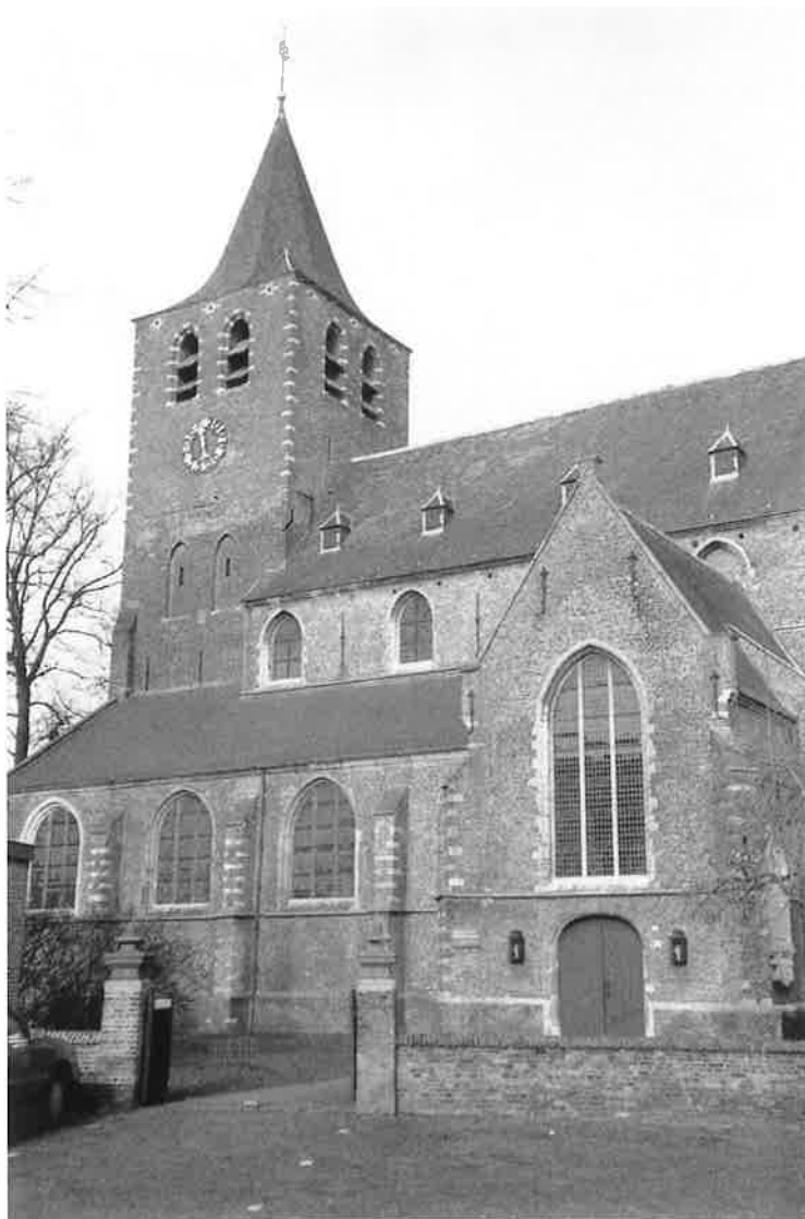
Kerkgebouw van de huidige protes- tante gemeente te Halsteren/Nieuw- Vossemeer.
