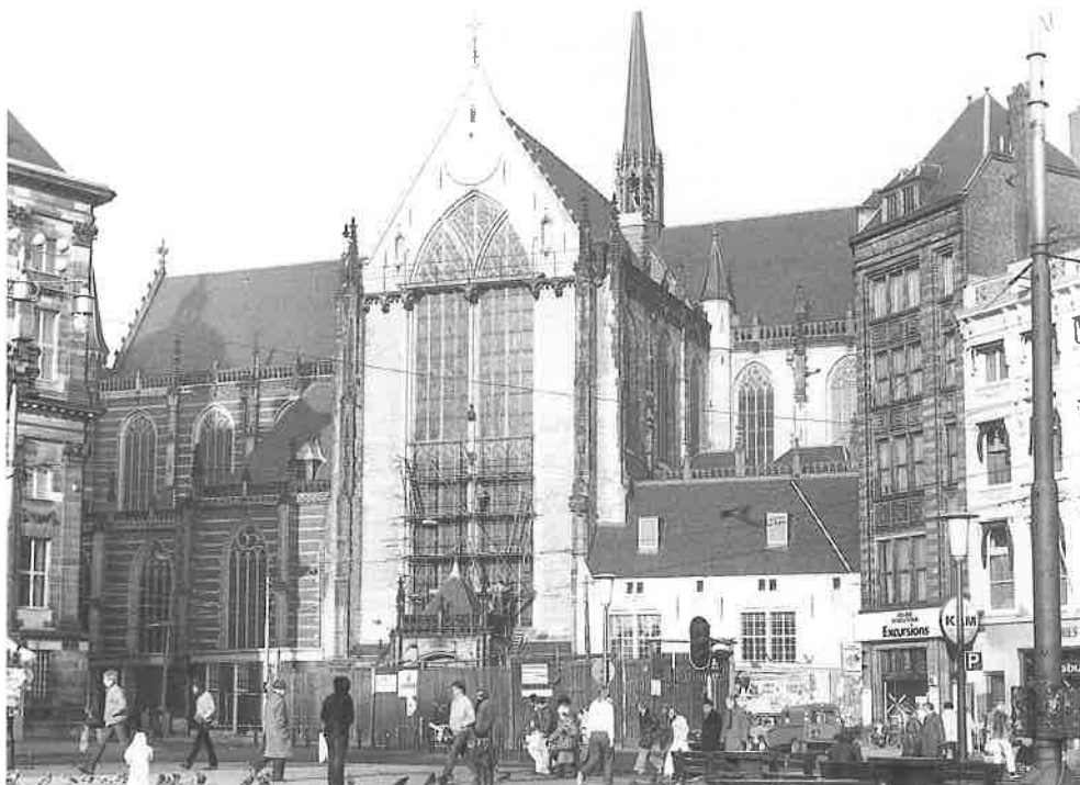
De "Nieuwe Kerk" (zuider transept) te Amsterdam begin 1980. Alleen wat schuttingen en een paar steigers herinneren nog aan de restauratie die 21 jaar heeft geduurd.
