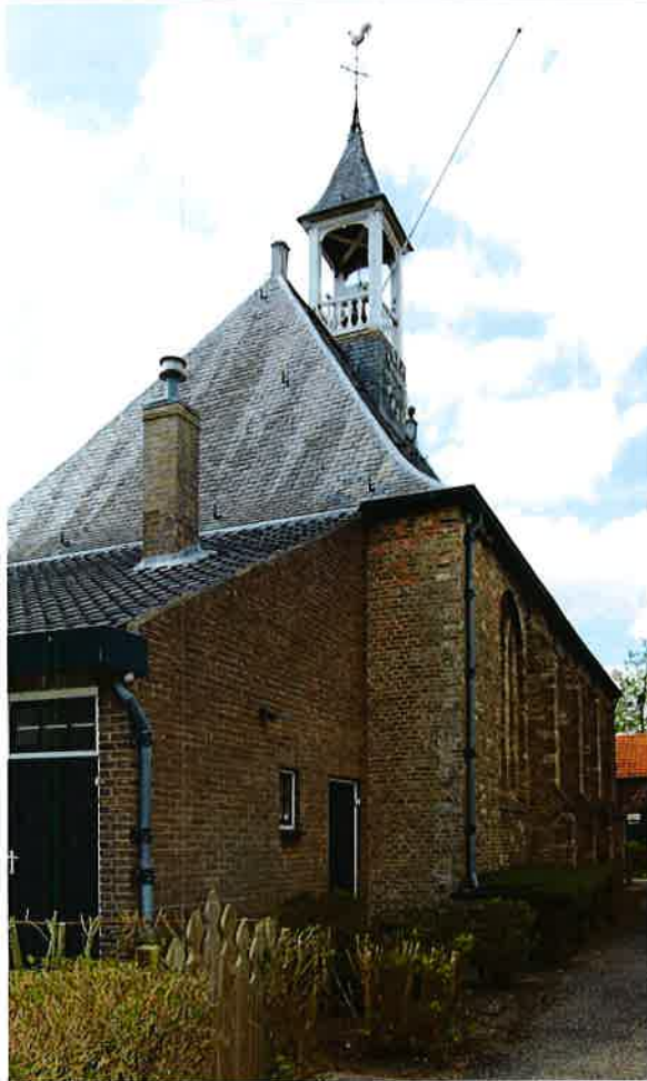
Kerkgebouw van de Hervormde gemeente te Nieuwvliet (1659).
