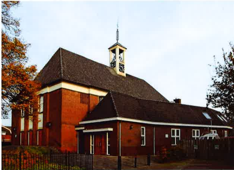
Kerkgebouw van de Hervormde gemeente te Bruinisse (1952).
