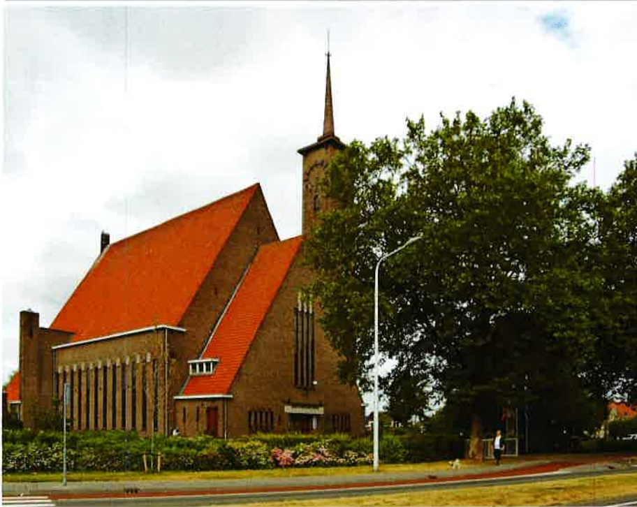
De voormalige Gereformeerde Westerkerk te Goes die sinds 2009 eigendom is van de Stichting Johannes Thielen.
