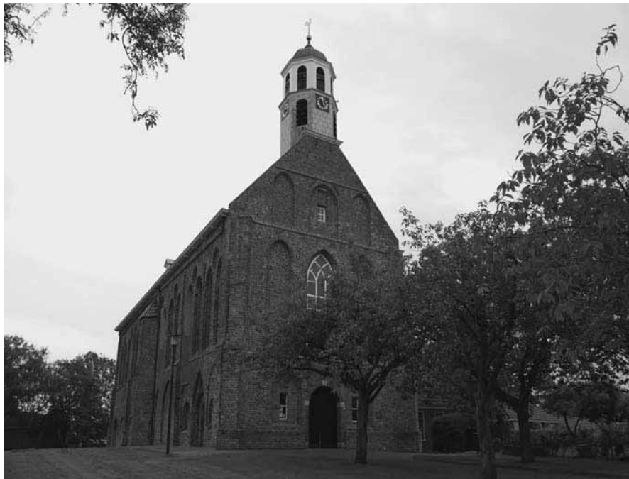
Kloosterkerk van de hervormde gemeente Ten Boer, waar de waterput dichtbij is gelegen.
