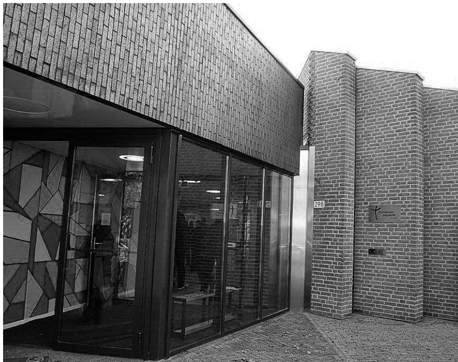
Het nieuw aangebouwde gedeelte aan de Oosterlichtkerk van Huizen.
