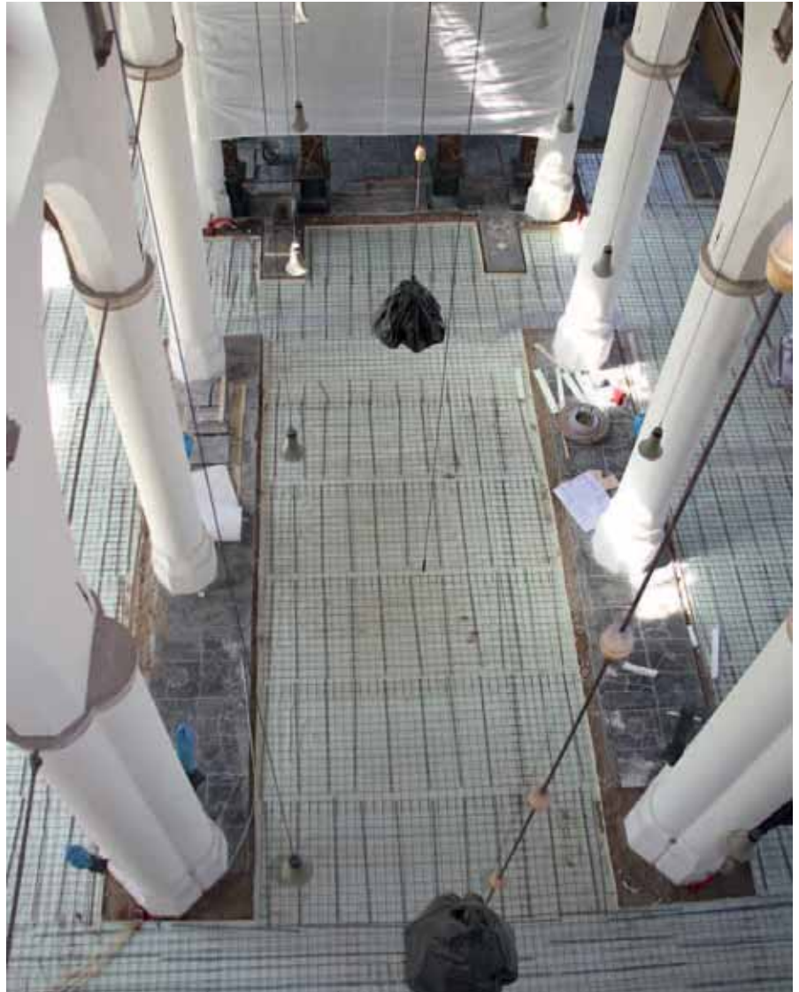
In de Barbarakerk werd 525 m 2 vloerverwarming aangelegd (foto: Dik Hooijer).
