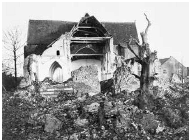
De Maartenskerk vanuit het westen gezien na het opblazen van de toren. Op de voorgrond liggen de resten van de toren. Een deel van het schip en de noordelijke zijbeuk staan nog overeind. Het transept heeft de aanslag redelijk goed overleefd, al is het kruisingsgewelf zwaar beschadigd (foto RCE 303741).
