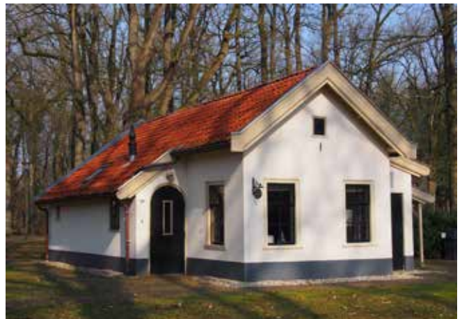
Voormalige kosterwoning Koepelkerk Veenhuizen
