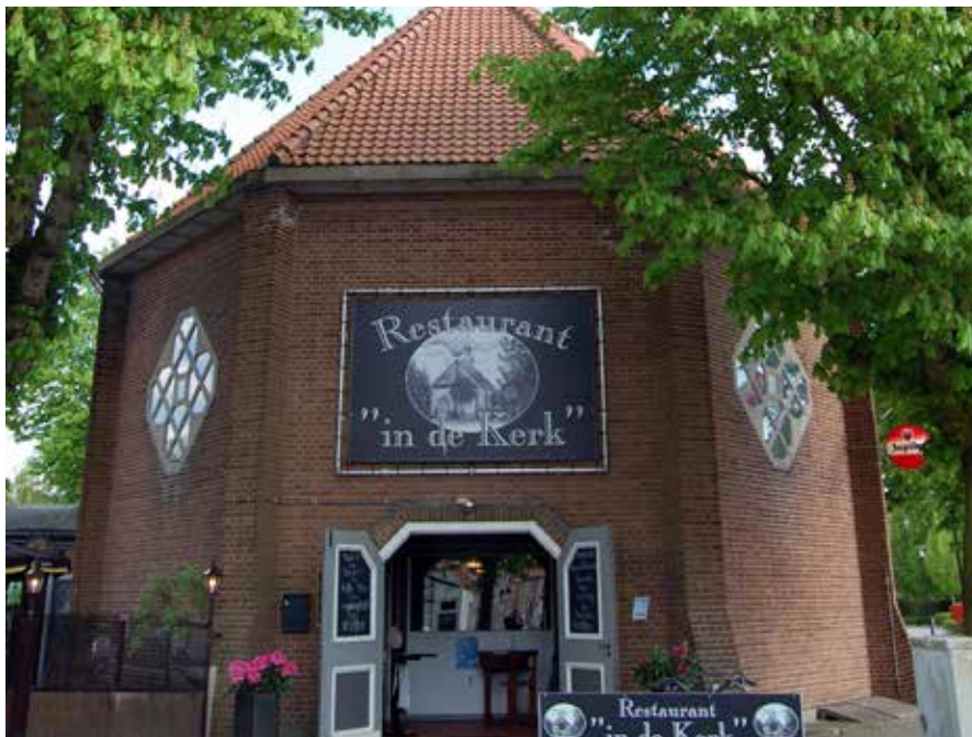
Voormalig landgebouw te Zuidzande, dat nu restaurant is
