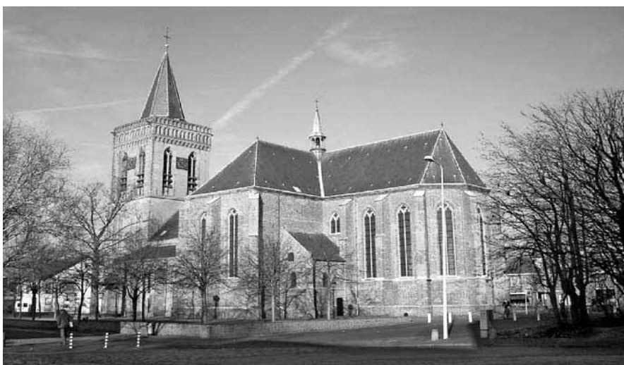
Kerkgebouw als schil tussen binnen- en buitenklimaat. De schil is samengesteld uit vloer, muren, ramen en dak en werkt als vertragende factor op het warmte-transport van binnen naar buiten of van buiten naar binnen (archieffoto: Oude kerk te Ede).
