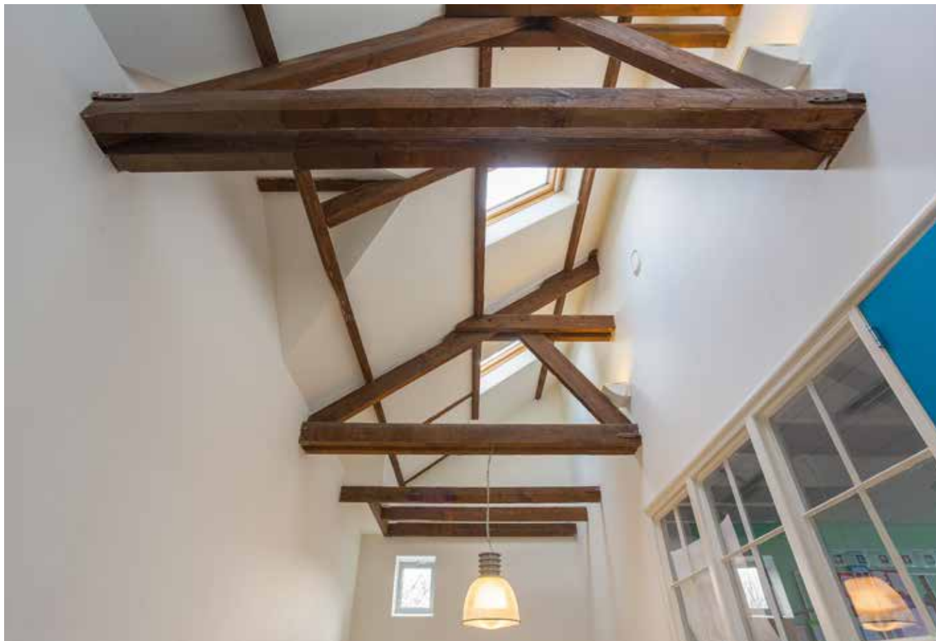
Deel van de gerenoveerde Burgemeester Amersfoordtschool te Badhoevedorp
