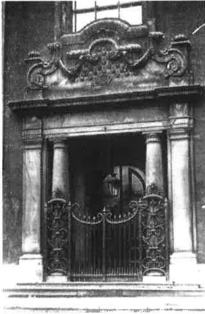
Ingangsdeur van de door een Duits bombardement in mei 1940 verwoeste Evangelisch-Lutherse Kerk aan de Wolfshoek te Rotterdam.
