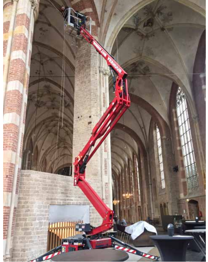
Aanleg van verlichtingsarmaturen in de Lebuïnuskerk in Deventer
