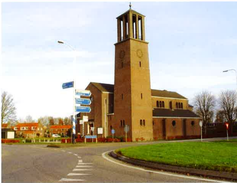
Kerkgebouw Bant in de Noordoostpolder (1955), destijds gebouwd door de Rooms-Katholieke parochie, maar in 2004 gekocht door de Protestantse gemeente.
