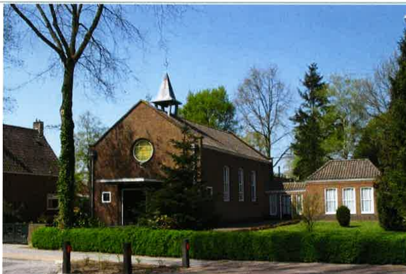
Kerkgebouw van de Gereformeerde kerk van Rouveen (1953).
