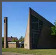
Waalwijk, 44 senioren appartementen met ontmoetingsruimte.
