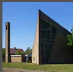
Waalwijk, 44 senioren appartementen met ontmoetingsruimte.
