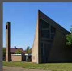
Waalwijk, 50 senioren appartementen met ontmoetingsruimte.
