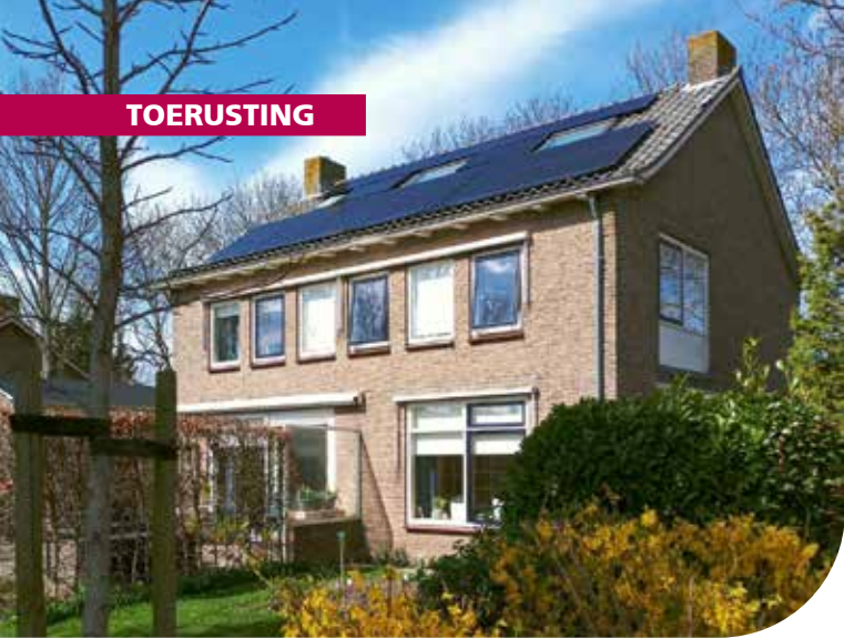
Zonnepanelen op het dak van de pastorie in Sommeldijk
